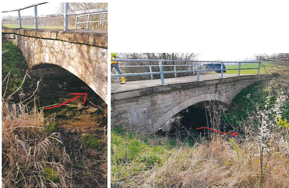
Foto 10-11: Blick auf die Feldwegbrücke westlich der Gemarkungsgrenze zu Niederzimmern
