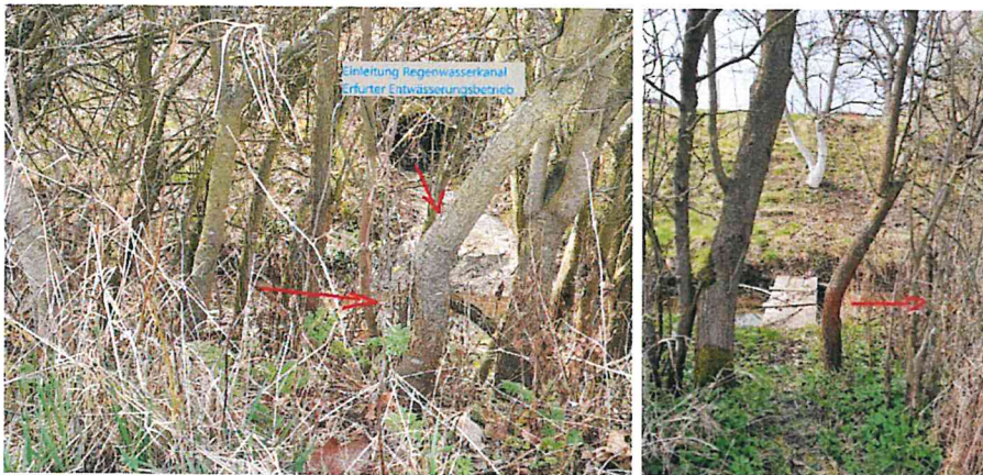
Foto 15-16: Einleitung eines Regenwasserkanales des Erfurter Entwässerungsbetriebs aus der linken Böschung oberhalb des Flurstücks 226/7 und (inoffizieller) Steg oberhalb von Flurstück 226/13
