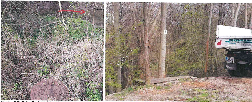
Foto 30-31: Schacht mit unbekanntem Ursprung (bespannt) und Uferverbau einschließlich Parkplatz im Gewässerrandstreifen in der KGA am Kirschberg
