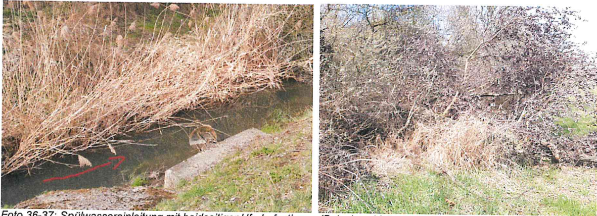
Foto 36-37: Spülwassereinleitung mit beidseitiger Uferbefestigung (Beton) und Impression vor der Kläranlage
