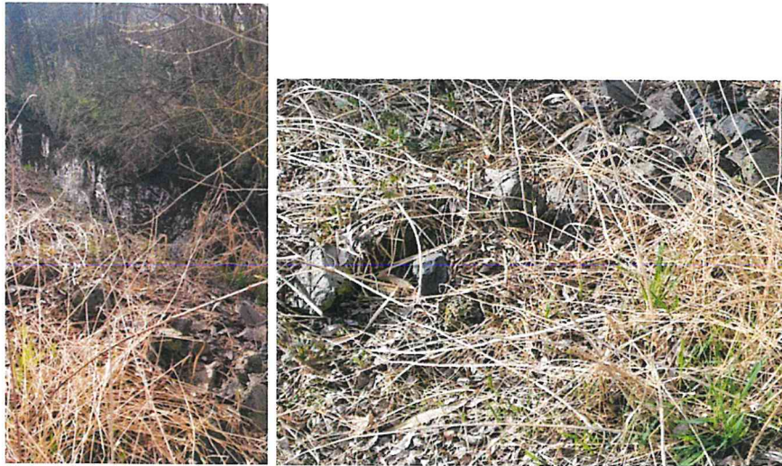
Foto 8-9: Schlackesteine an der Böschungsoberkante und im Gewässerrandstreifen
